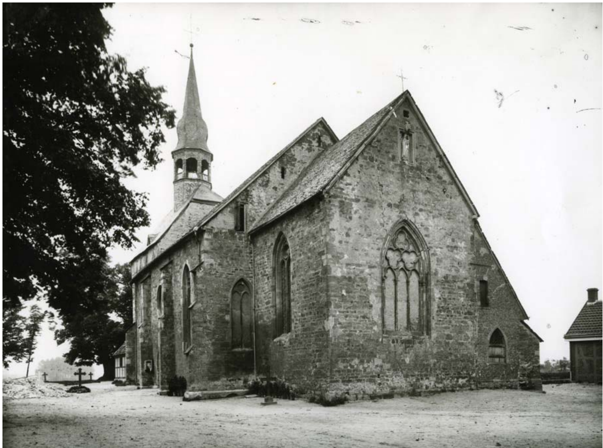
St.-Marien-Kirche mit Sakristei (Anbau rechts), Ansicht von Südosten, 1890 (Foto Westfälisches Amt für Denkmalpflege, Münster)
