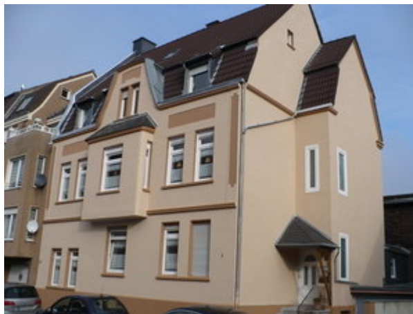
Gebäude Düppelstraße 2 nach der Fassadenerneuerung
